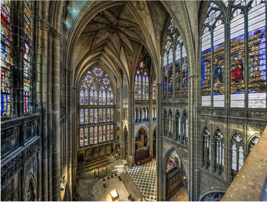
Metz : Les murs s'effacent, il n'en reste qu'une clairvoie d'arcs en tension équilibrés les uns sur les autres.. (gothique)
