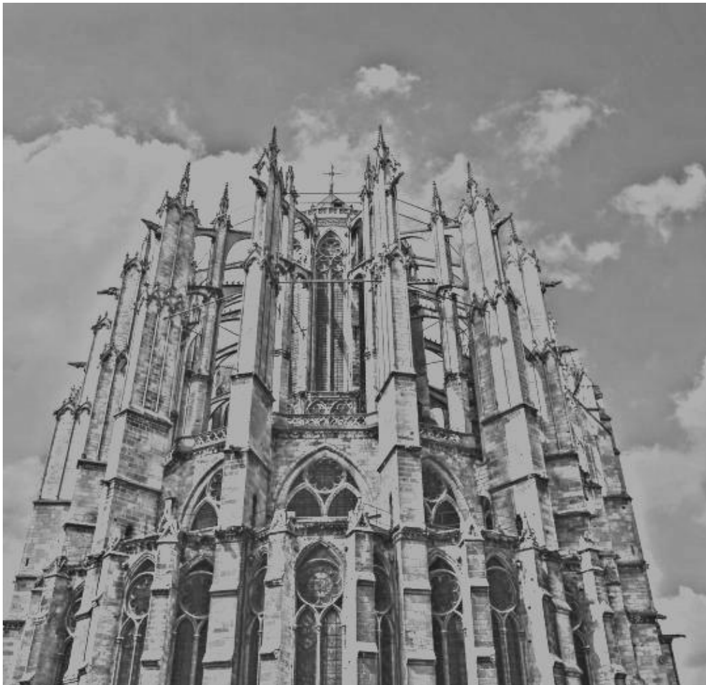
Grâce à cette mise en tension équilibrée des arcs les uns au bout des autres, toute la masse de la construction nécessaire à sa stabilité est repoussée à l'extérieur grâce à la technique de l'arc-boutant (Cathédrale de Beauvais)
